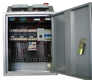
Schaltkasten Stern-dreieckschaltung
